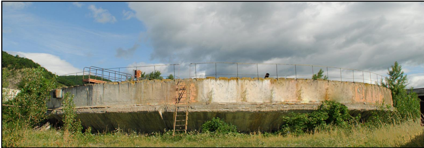
Decantorul suspensional
