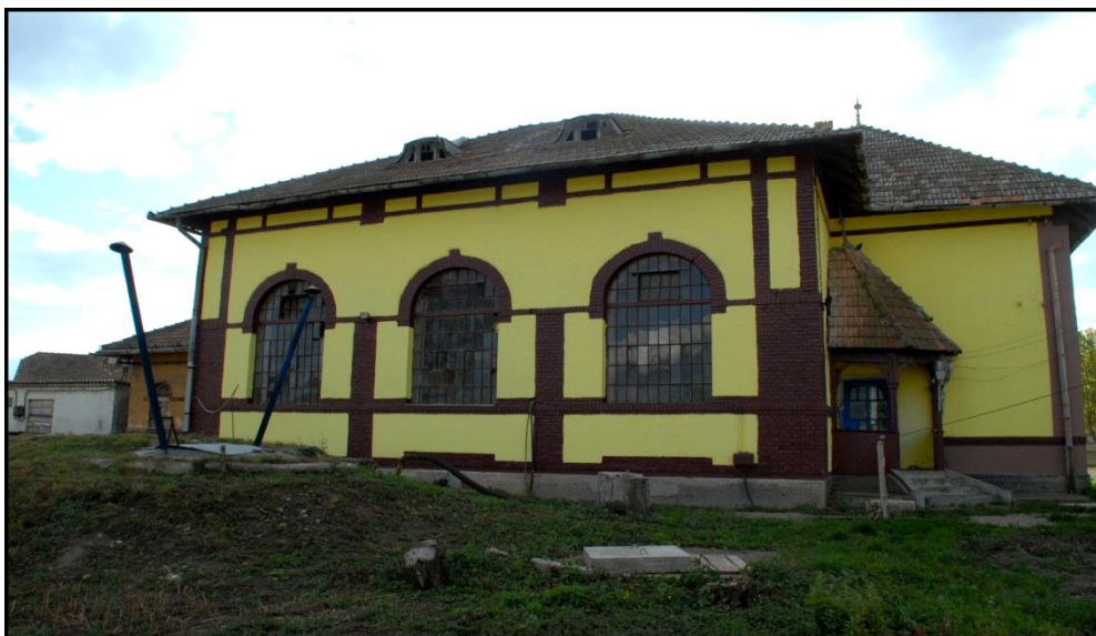
Stația de pompare Turda Veche
