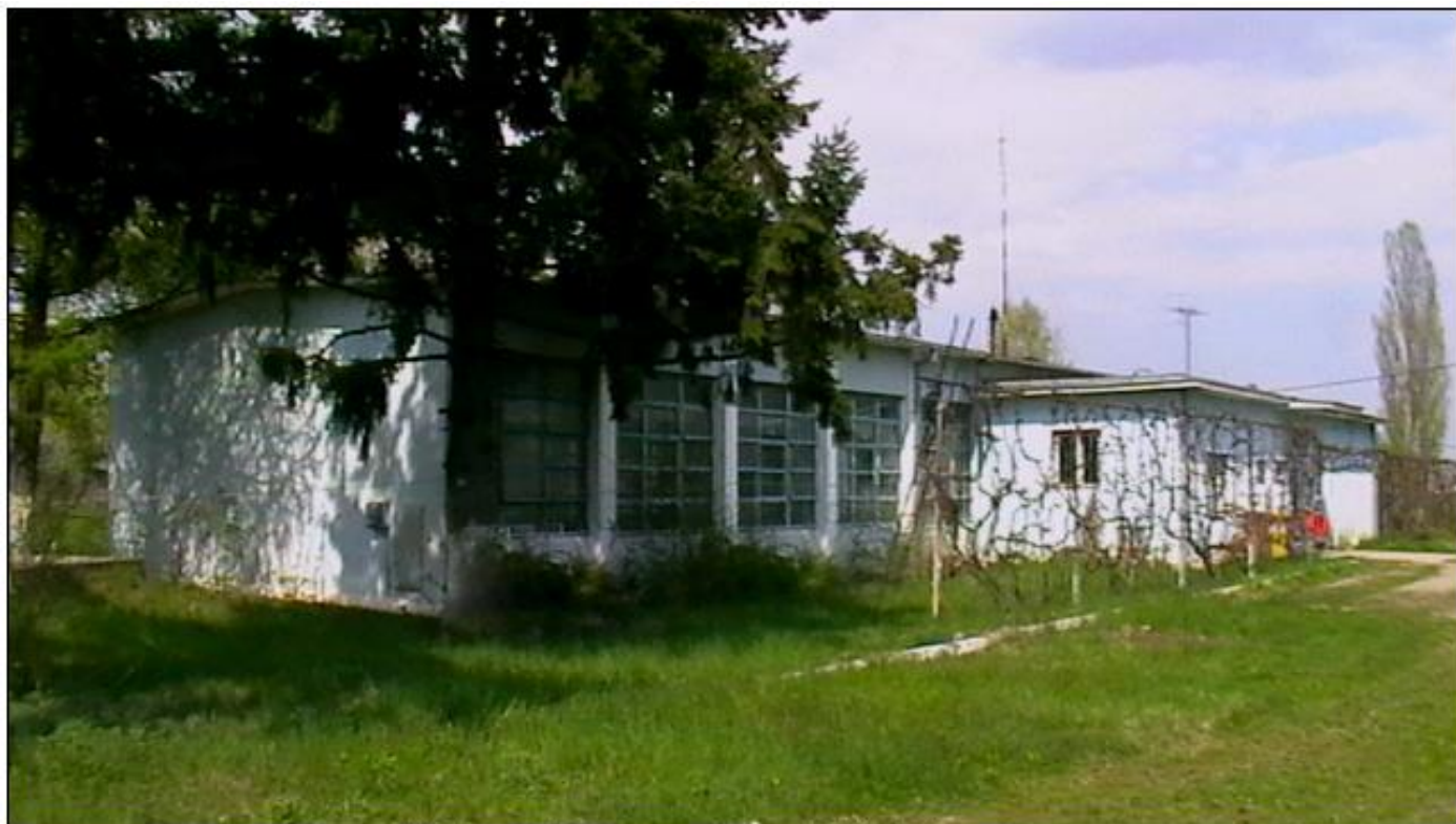
Clădire stație de pompare nouă Mihai Viteazu
