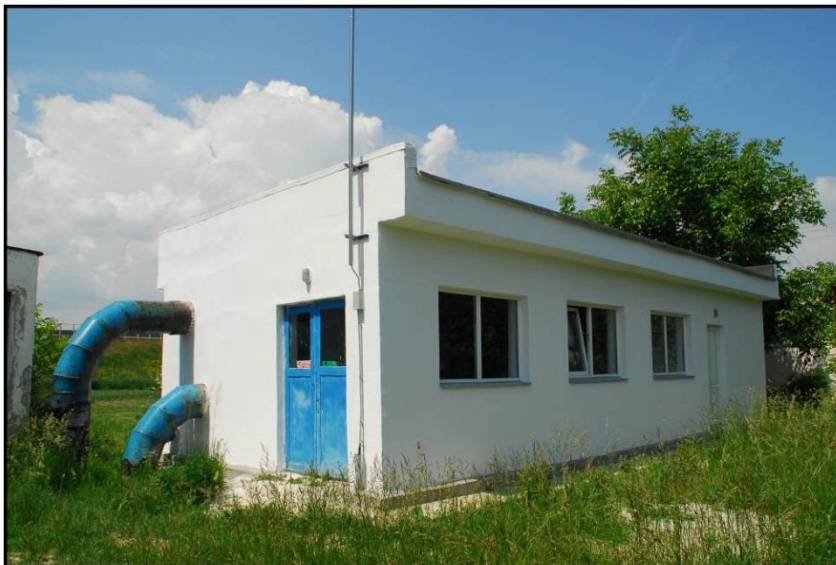
Sursa Varianta – Stația de pompare
