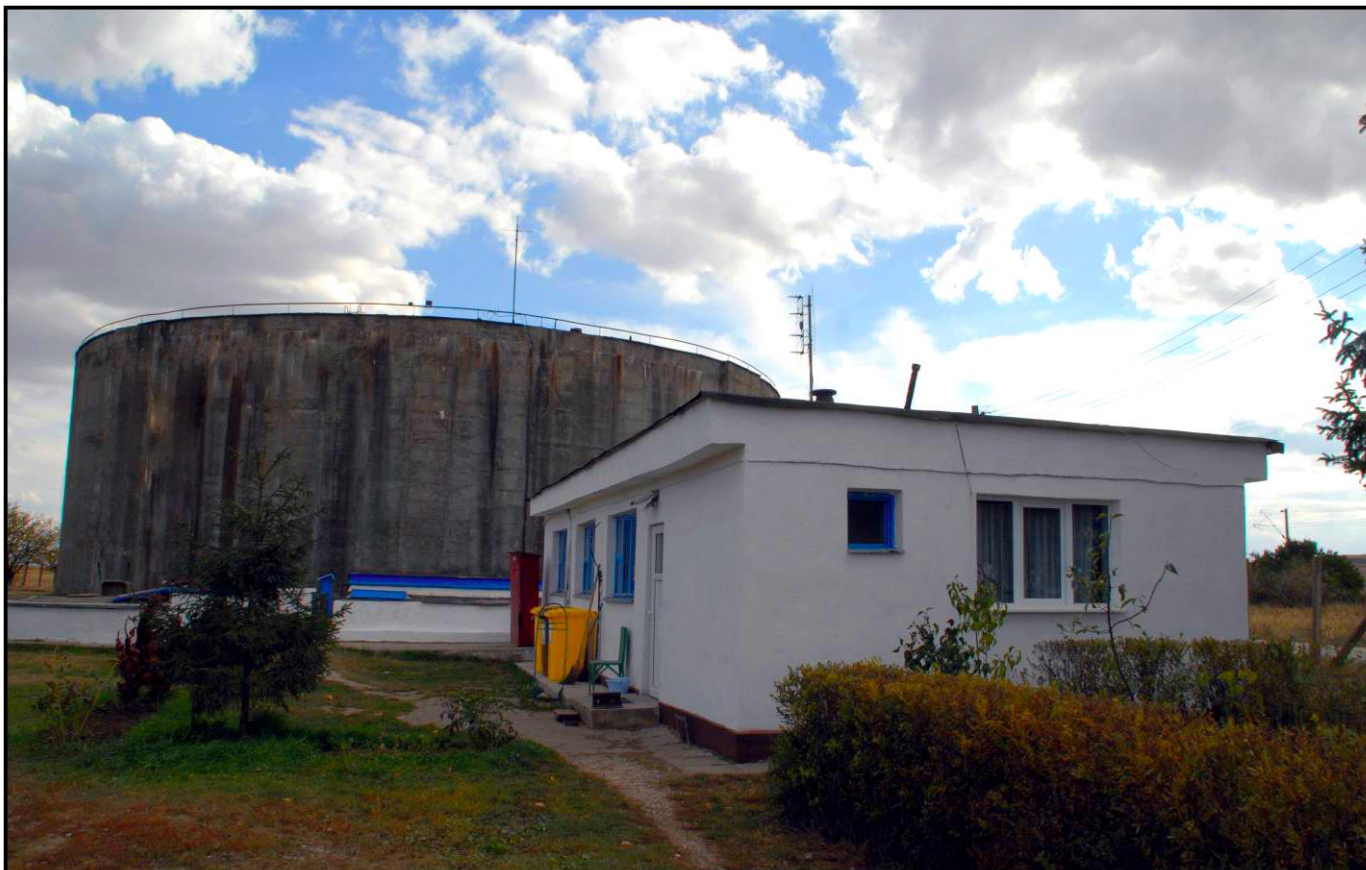
Sursa Călărași – Stație de pompare și Rezervor 5000mc
